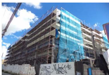
Vista lateral Av. Cristiano Machado
