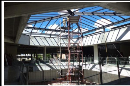
Estrutura Metálica - Átrio
