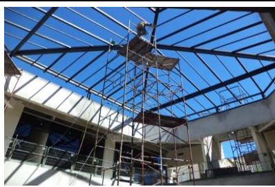
Estrutura Metálica - Átrio
