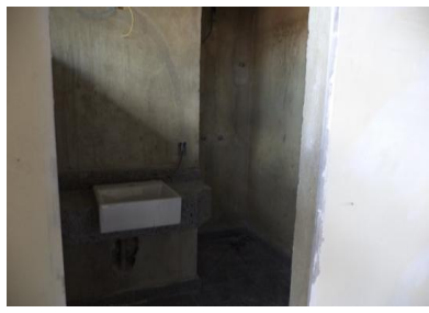
Banheiro de Gabinetes
