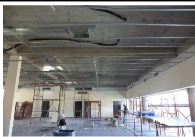
Esperas para instalação Placas de Gesso - Administração GOB / Secretarias
