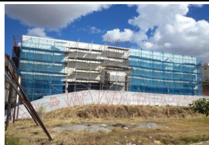
Fachada lateral esquerda
